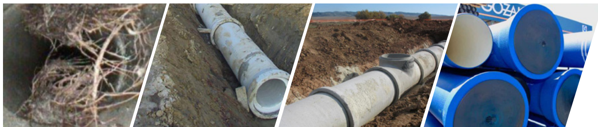
Foto 1: Inclusión de raíces en red de saneamiento a través de grieta en la tubería
